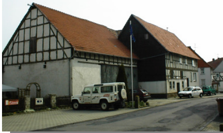
Haus in der Torstraße
